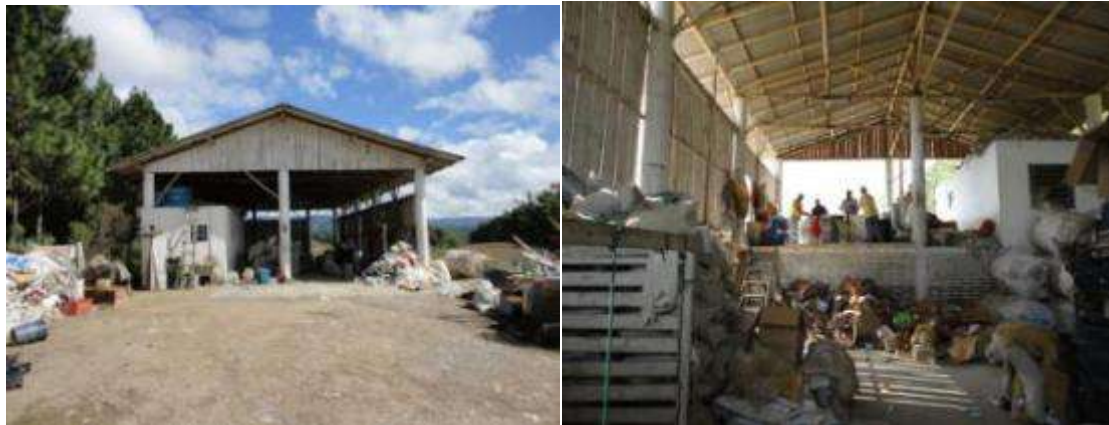
FIGURA 20 – Centro de Triagem de Petrolândia
