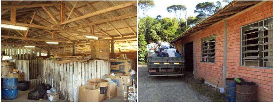
FIGURA 25 – Centro de Triagem de Vitor Meireles
