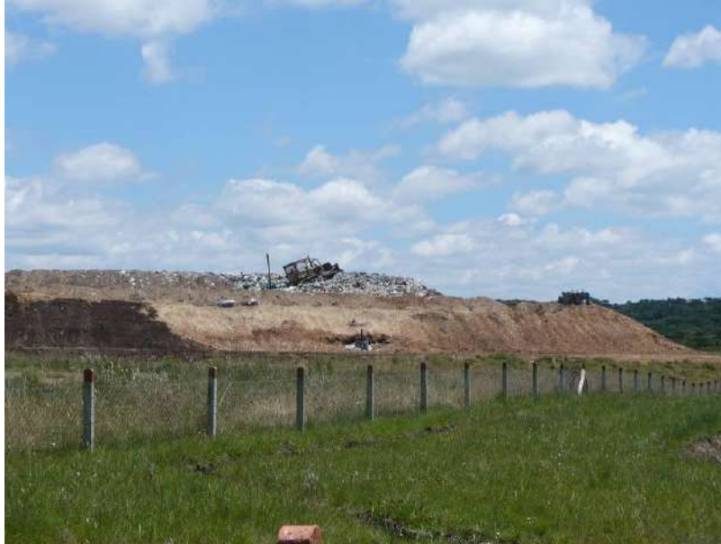
Figura 37: Compactação dos Resíduos – Lages/SC. Fonte: STE, 2010
