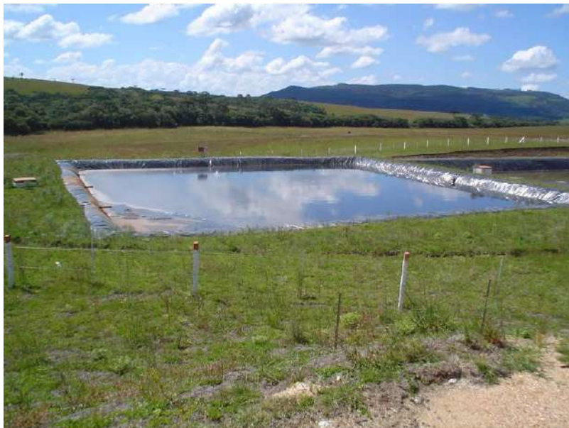
Figura 40: – Sistema de tratamento de líquidos percolados. Fonte: STE, 2010
