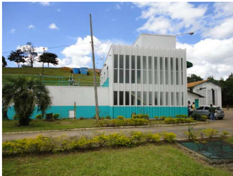
Figura 10: Vista Externa - ETA Rio do Sul. Fonte: STE, 2010
