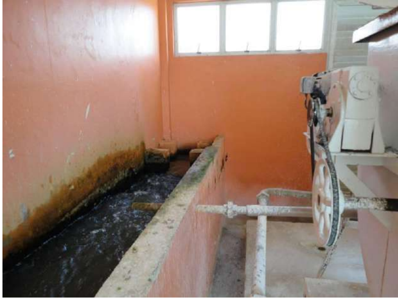
Figura 13: Desinfecção com cloro. Fonte: STE, 2010
