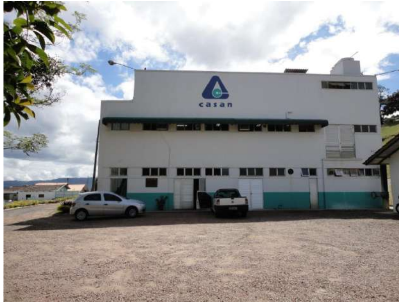
Figura 9: – Vista externa – ETA - Rio do Sul. Fonte: STE, 2010
