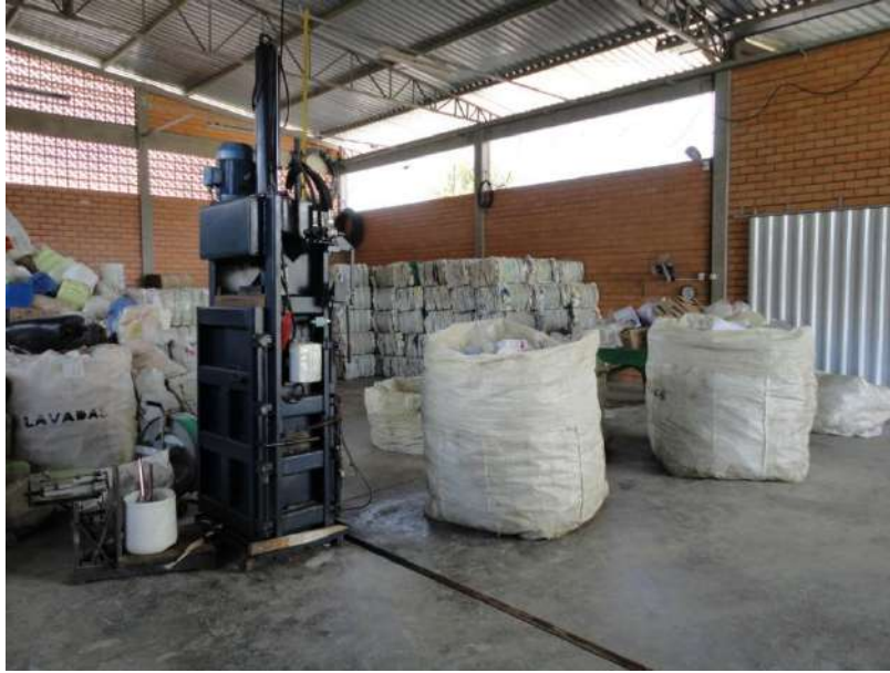
Figura 33: INPEV- Central de recebimento de embalagens vazias de agrotóxicos – Aurora. Fonte: STE, 2010
