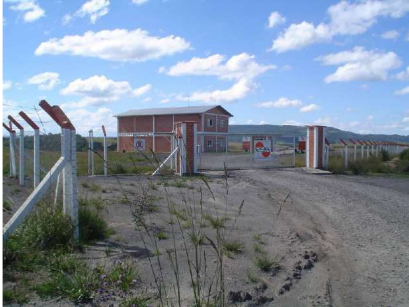
Figura 39: – Vista geral do Aterro Sanitário da empresa ESA em Lajes / SC. Fonte: STE, 2010
