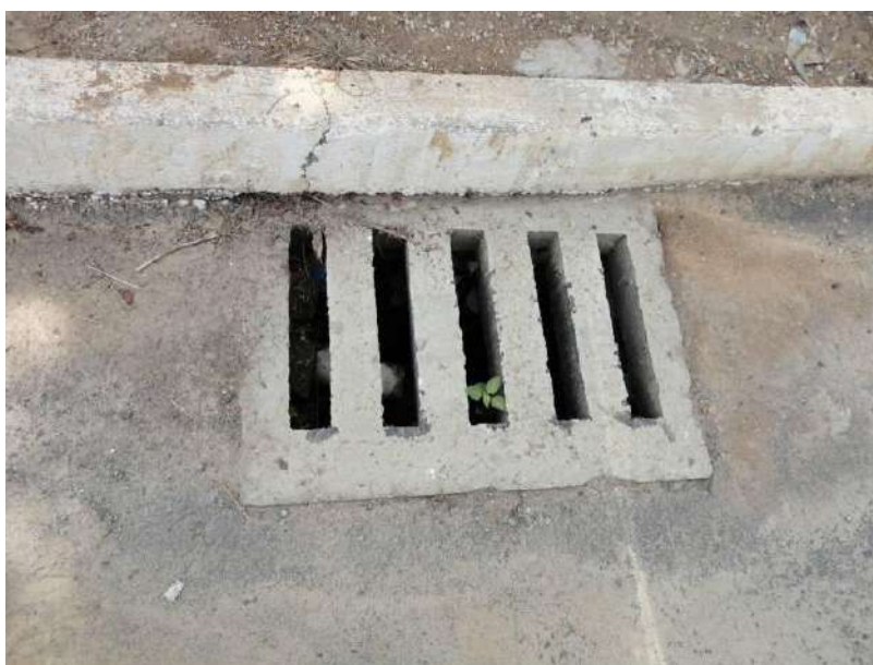
Figura 45: Boca de Lobo tipo grelha. Fonte: STE, 2010
