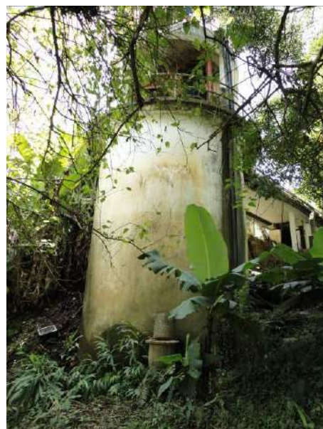
Figura 6: Elevatória de Água Bruta. Fonte: STE, 2010
