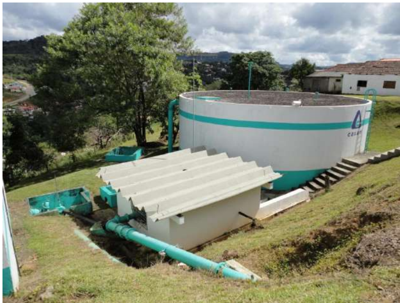
Figura 18: Reservatório localizado na ETA (Rio do Sul) com macromedidor. Fonte: STE, 2010
