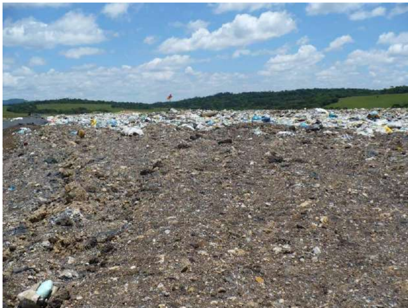
Figura 38: Compactação dos Resíduos – Lages/SC. Fonte: STE, 2010
