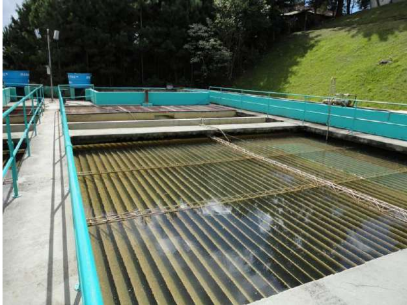
Figura 17: Floculadores em chicanas. Fonte: STE, 2010
