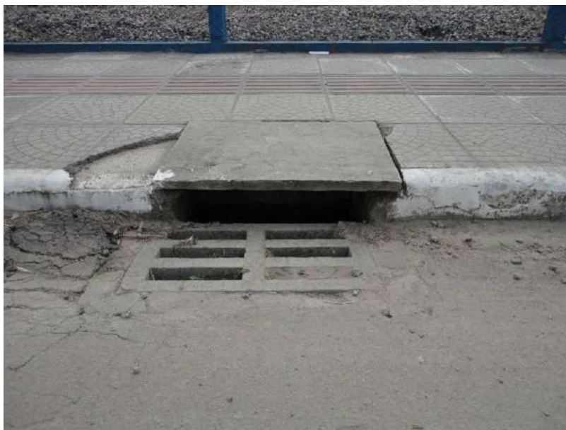
Figura 44: Boca de Lobo tipo grelha. Fonte: STE, 2010
